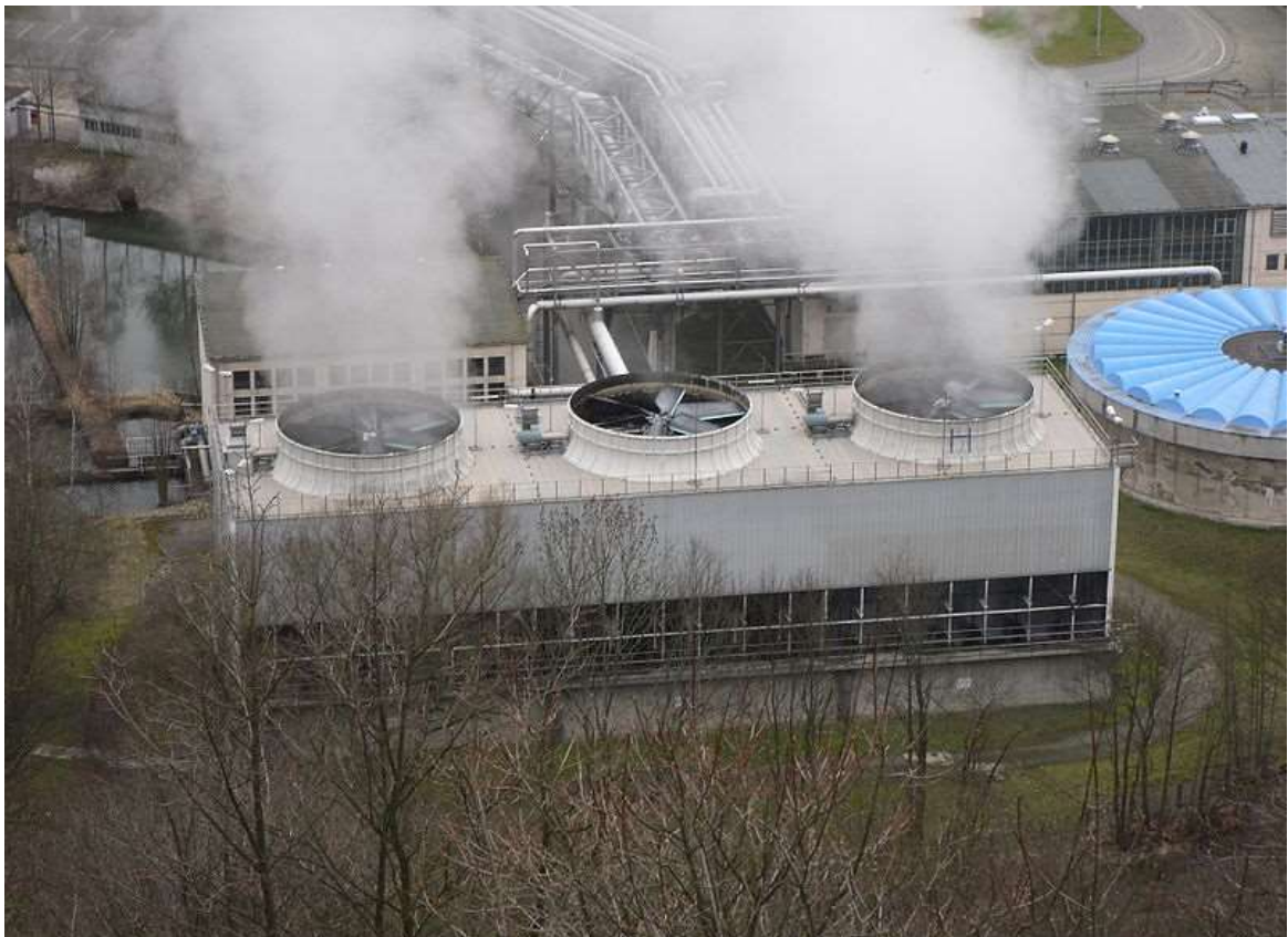
Abb. 17: kontaminierter Wasserdampf aus Kühlanlagen kann Legionellenepidemien auslösen
