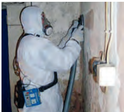
Schimmelpilzsanierung mit Putzfräse
