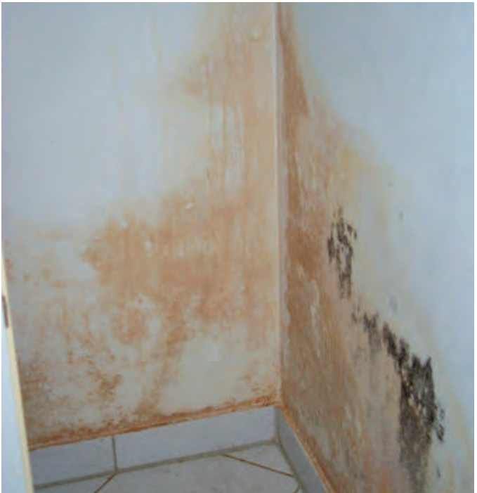
Geometrische Wärmebrücke
